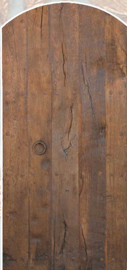
Puerta rústica española con grietas
